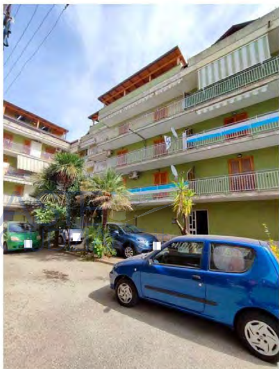
Foto 02. Vista del fabbricato Scala C dal cortile
