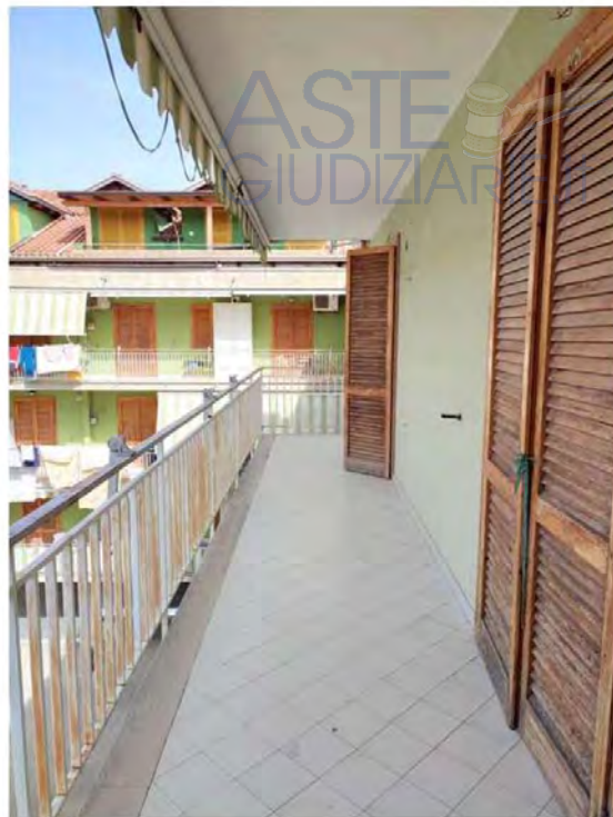
Foto 07. Balcone n.01 (lato soggiorno)
