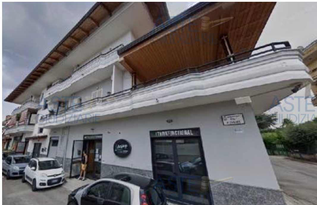
Fig. 2. Dettaglio dell'ingresso principale
