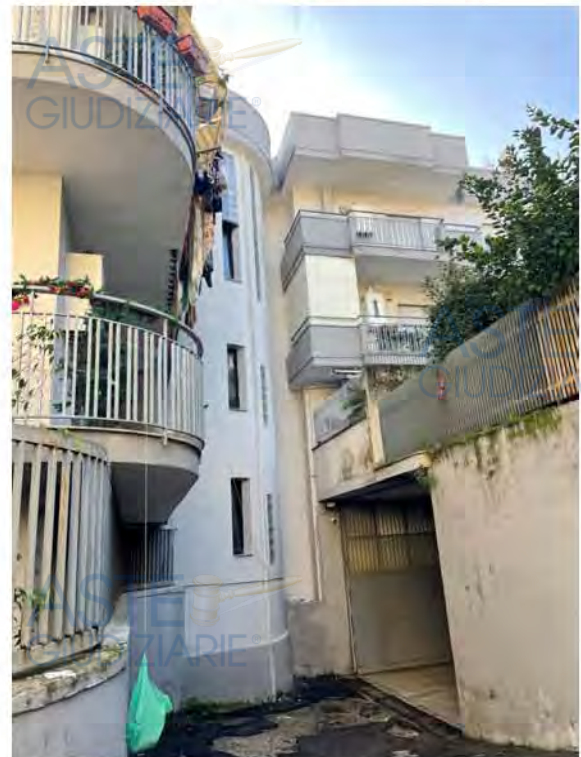
Fotografia n. 2 _ Prospetto scala comune
