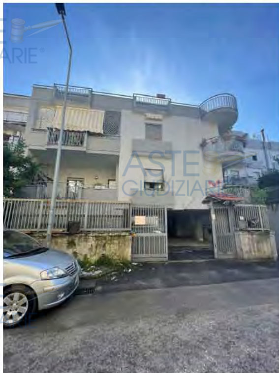
Fotografia n. 1 _ Prospetto su via Tolomeo
