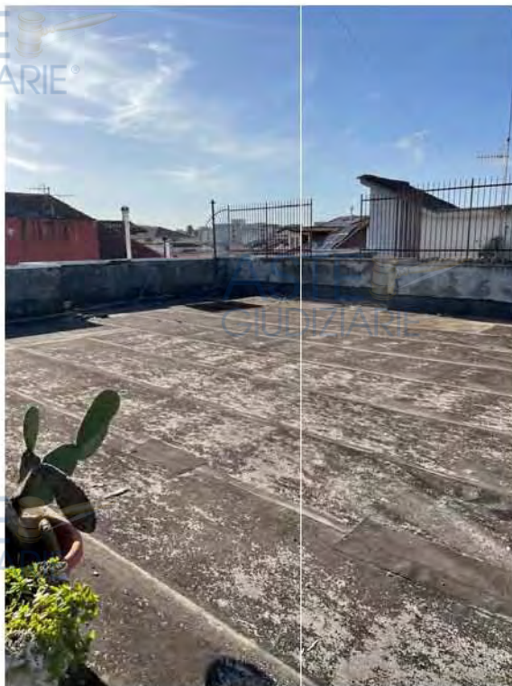
Fotografia n. 5 _ Lastrico solare esclusivo
