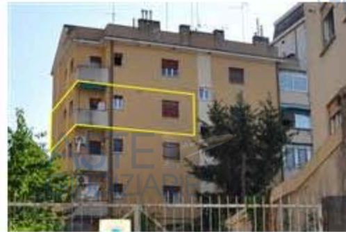
Condominio - Vista da Via Marzio Moro
