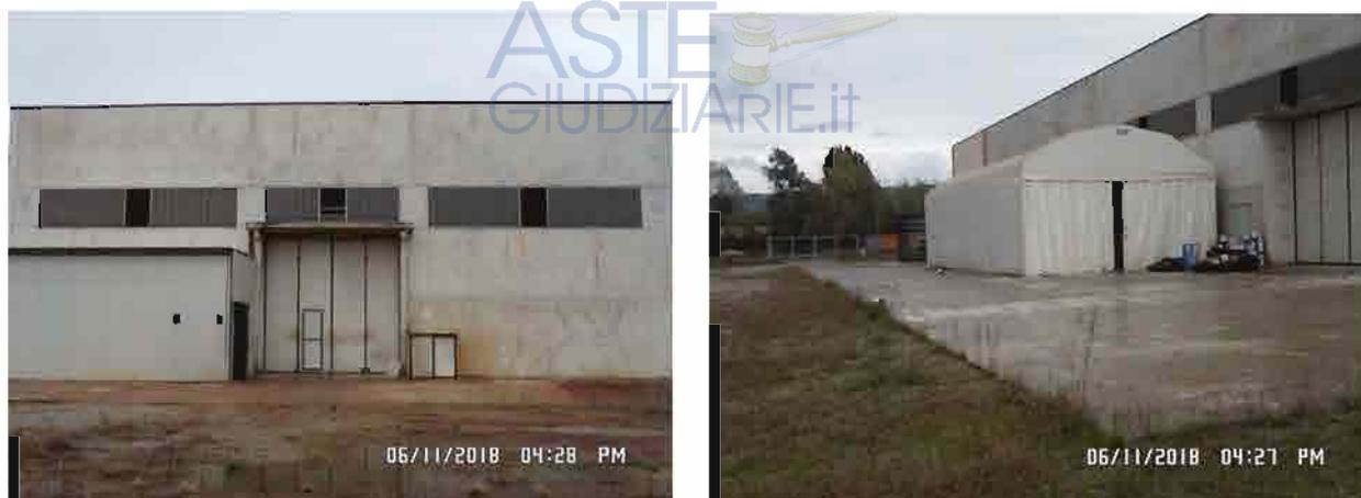
Sul perimetro esterno, trova posto un camminamento in cls della larghezza di mt. 1,50 sul lato est e mt. 3,50 sul lato ovest, mentre nella parte retrostante il capannone per una larghezza di mt. 10,00.
