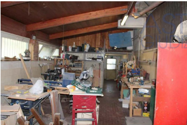
locali abusivi lato est
