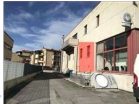
vista stato di fatto esterni
