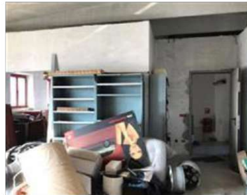
vista stato di fatto uffici piano primo
