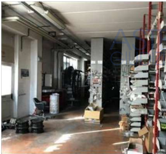
piano interrato deposito
