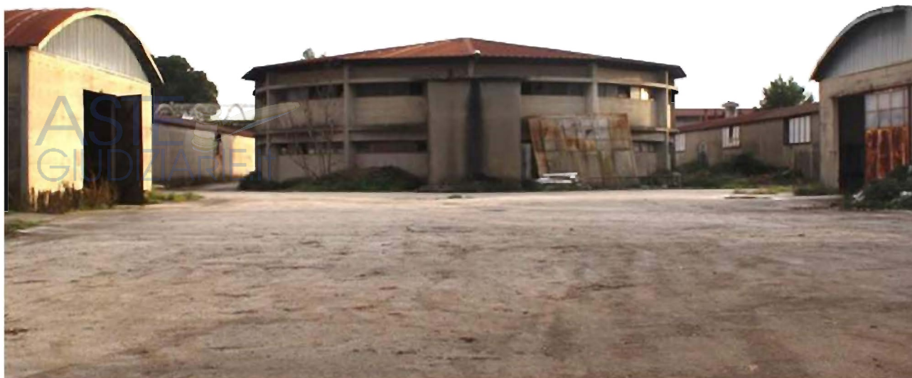
Fabbricato L – Prospetto nord
