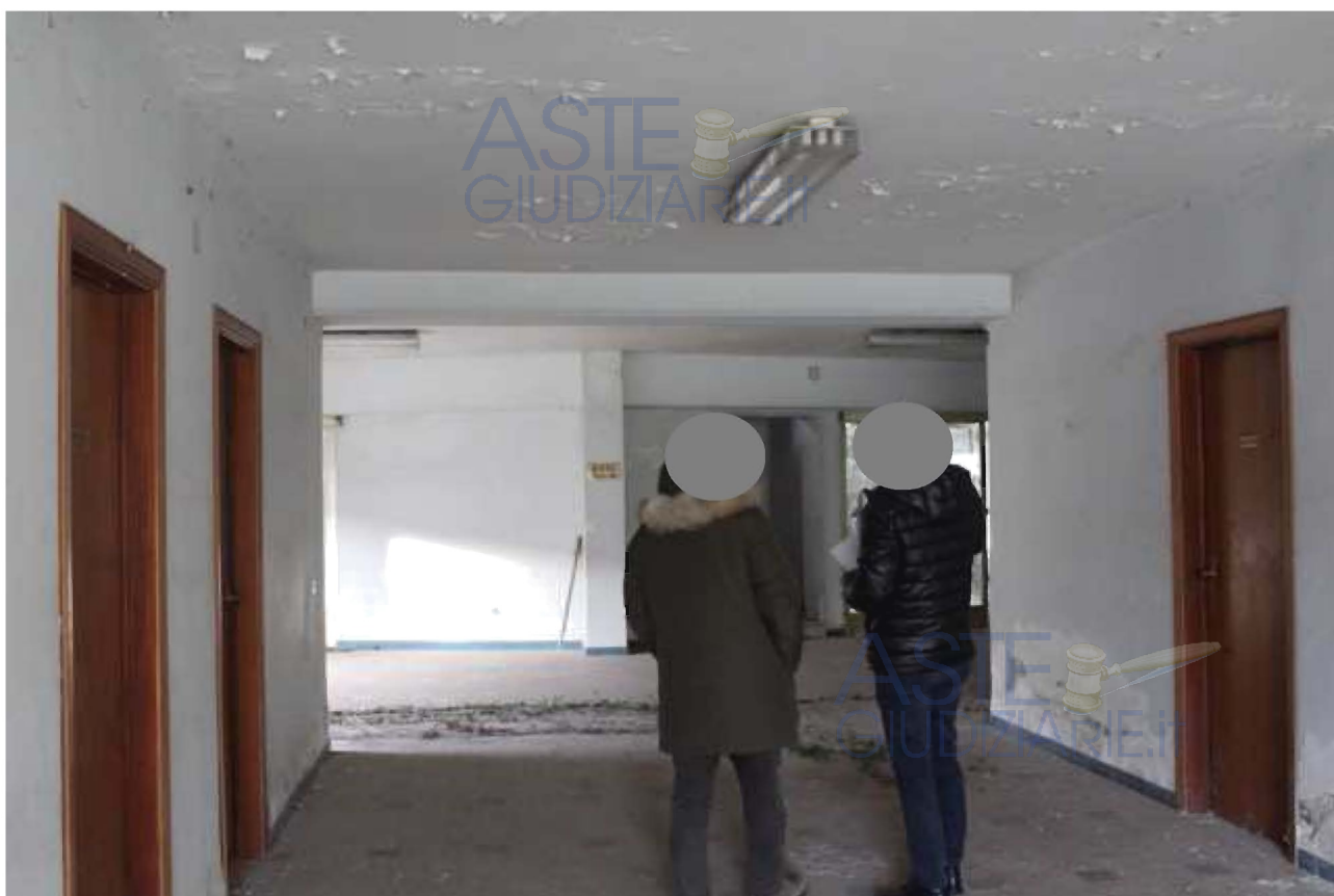
Fabbricato L – Interno piano terra
