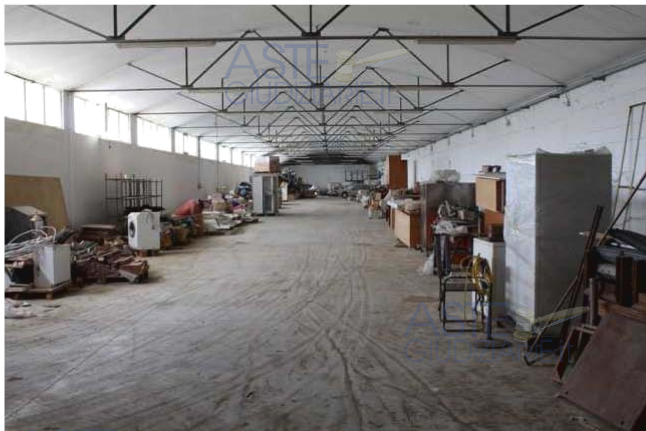
Capannone A - Interno
