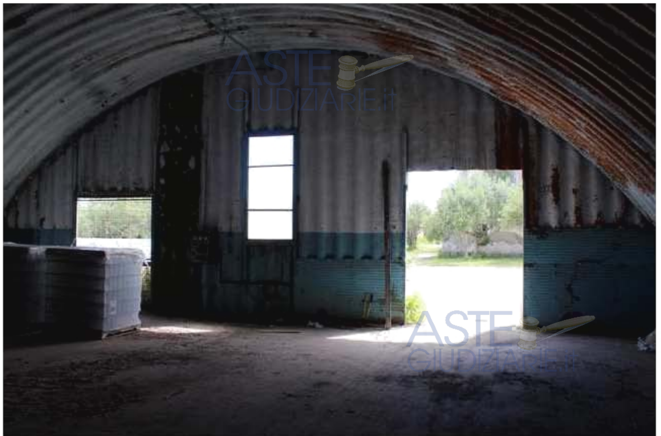
Capannone B - Interno
