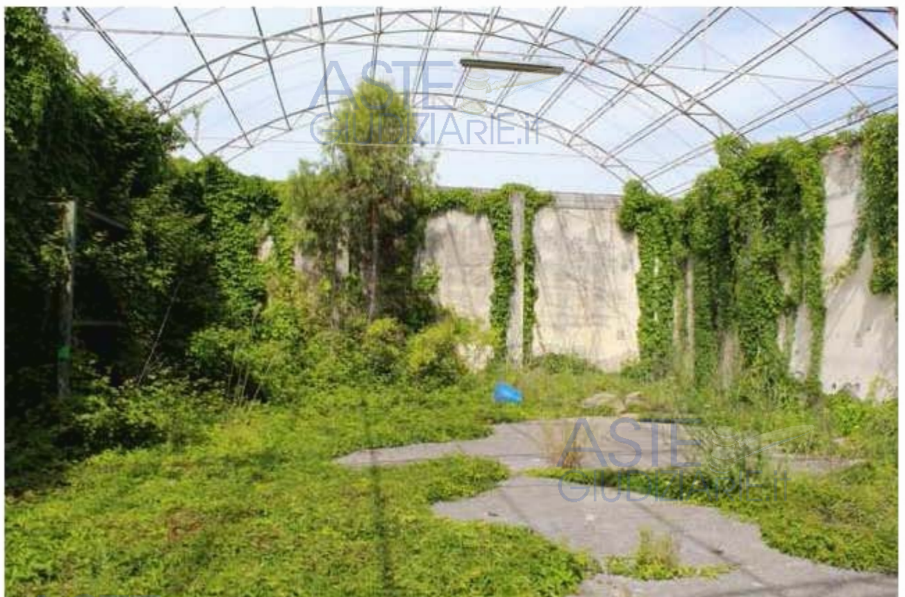
Capannone A - Interno
