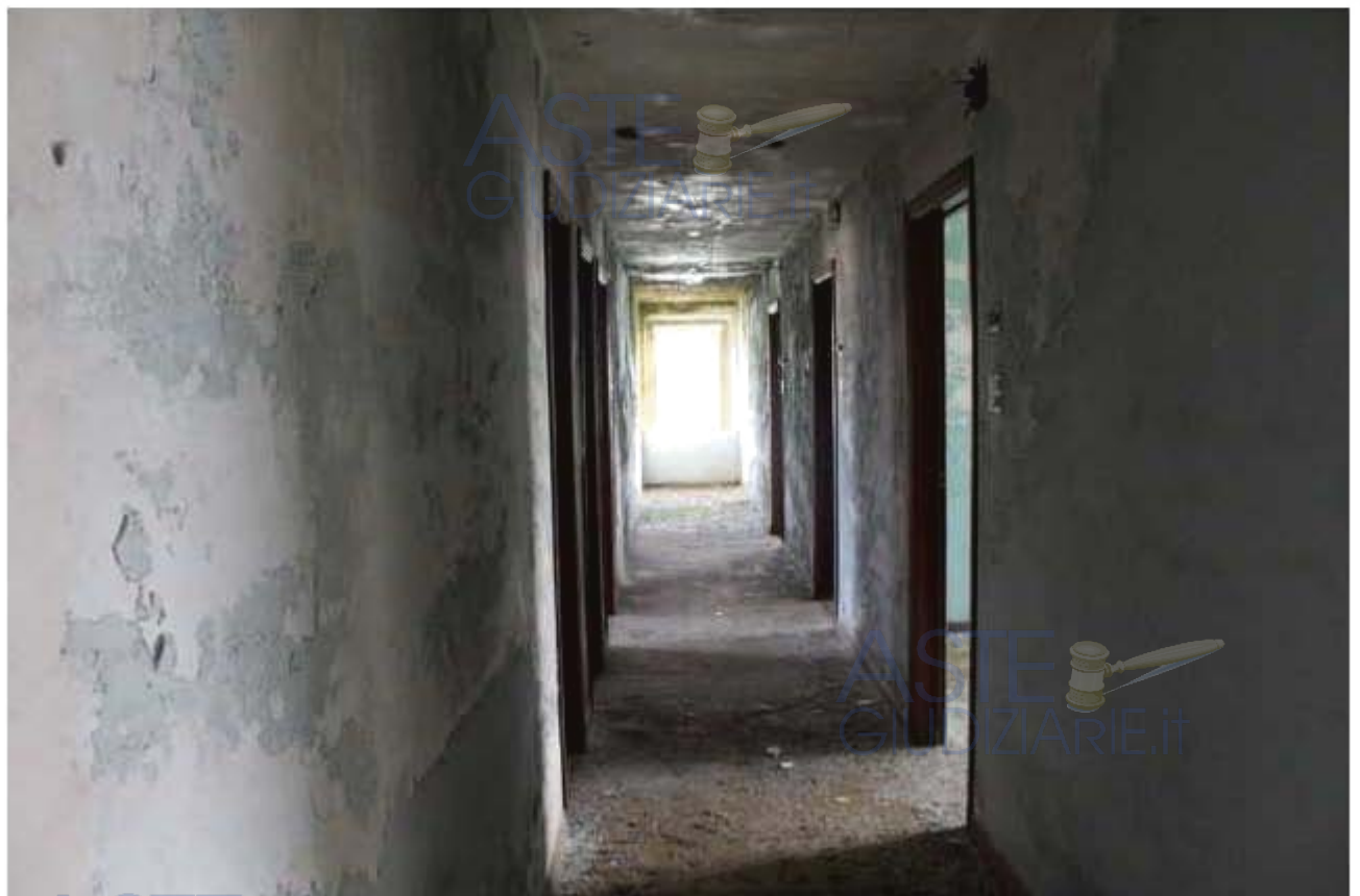
Fabbricato L – Interno primo piano
