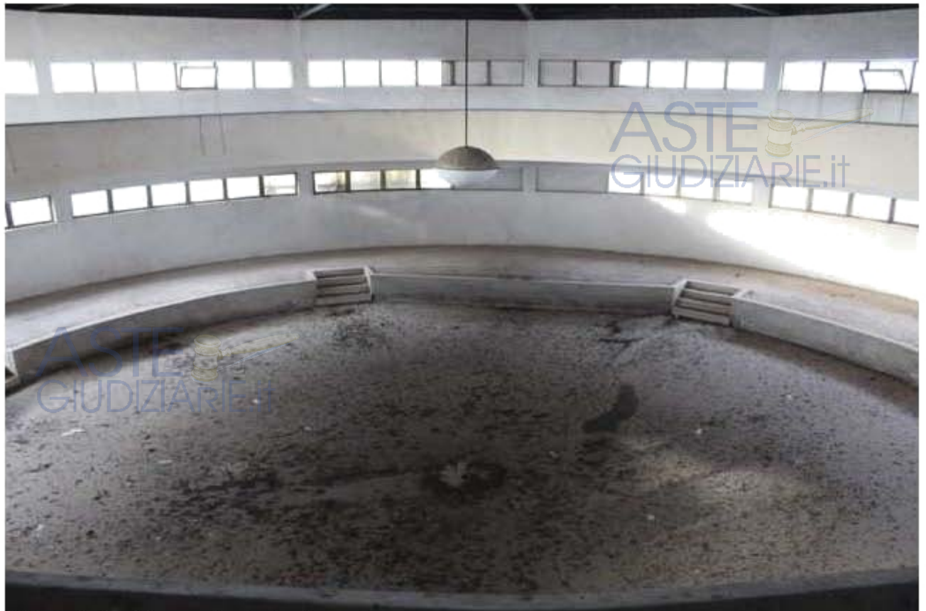
Fabbricato L – Interno sala riunioni
