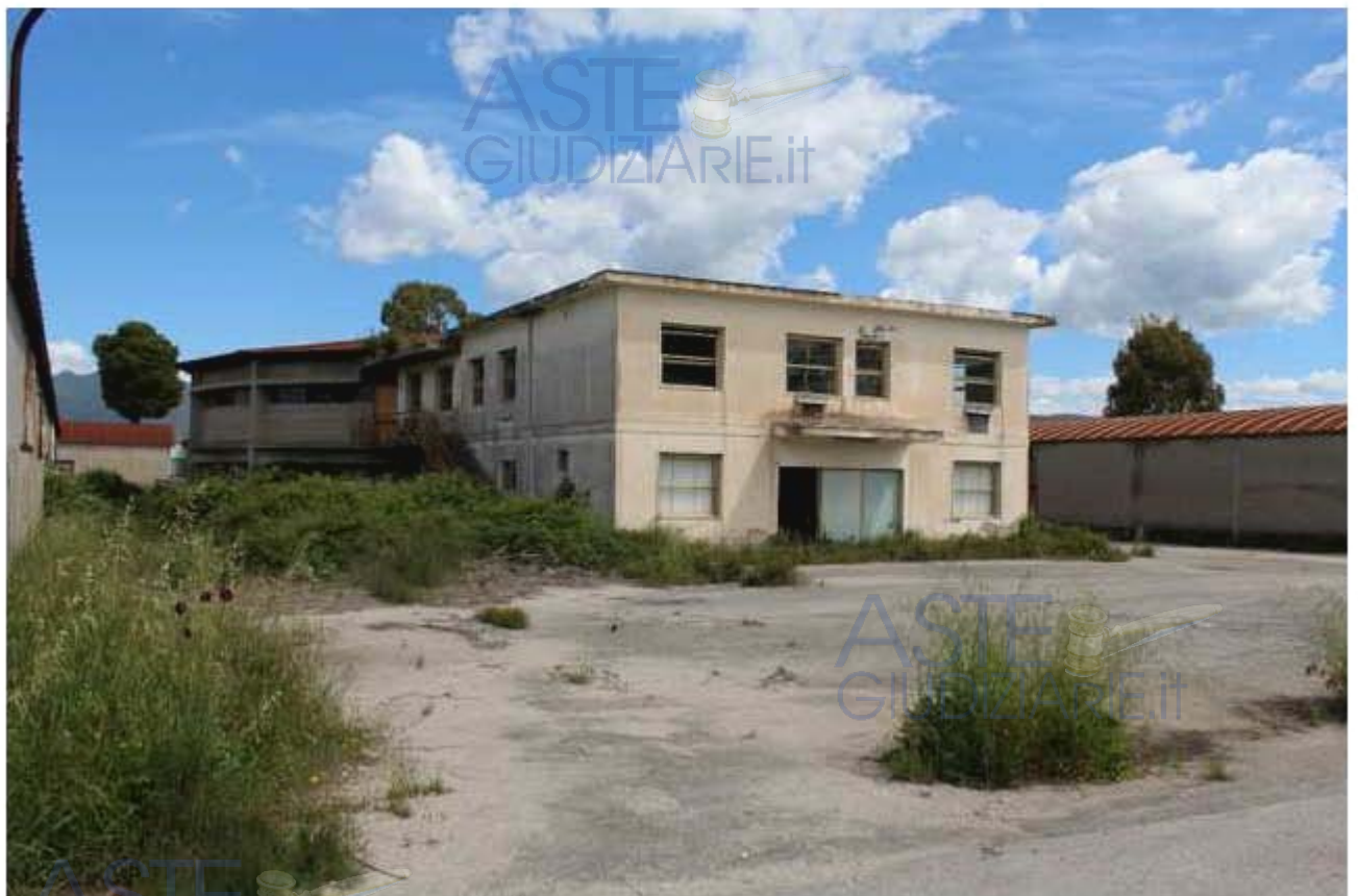
Fabbricato L - Prospetto sud con porta d'ingresso
