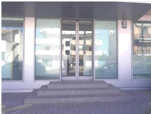
Vista ingresso negozio sul fronte su via B. Croce
