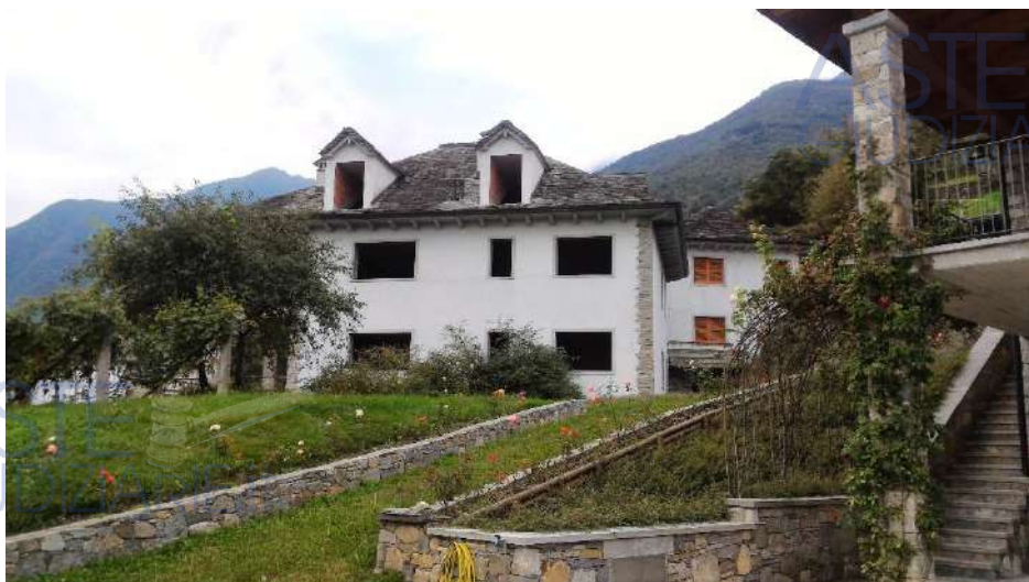
Prospetto edificio A con scorcio edificio B
