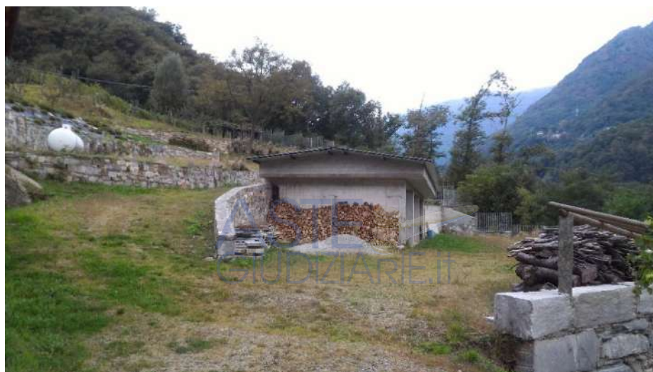
Vista edificio E
