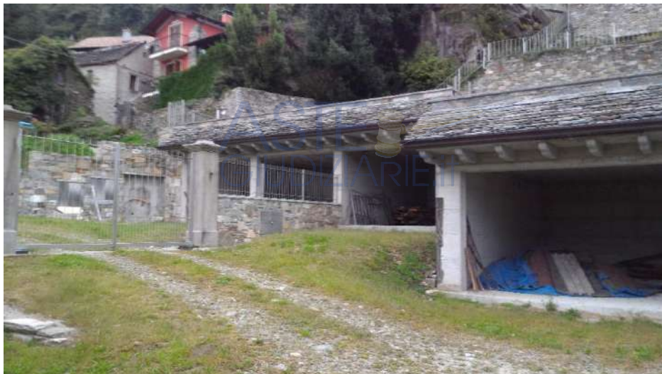
Particolare edificio C e scorcio autorimesse edificio A
