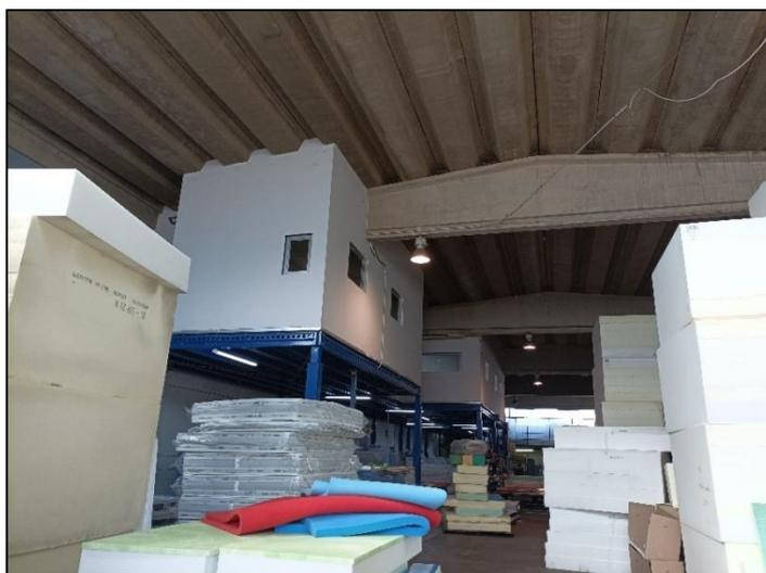
**RILIEVO FOTOGRAFICO INTERNI OPIFICIO**, costituito da ampio Piano Terra, adibito alla produzione/manifattura nonché ad uffici e a vani WC. Il Calpestio in massetto cementizio liscio e gli elementi modulari della copertura poggiano su travi in cemento armato precompresso.
