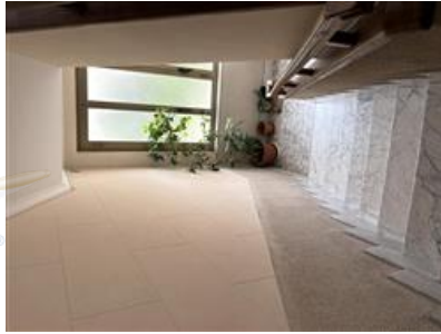
Vano scala dello stabile
