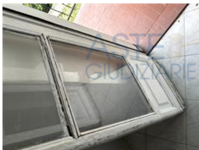
Particolare dell'infisso del balcone verso cortile
