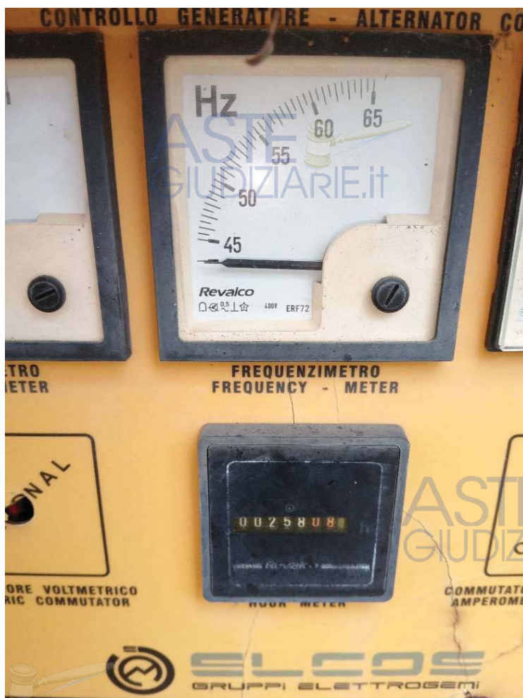
Foto 39 Particolare ore lavorate
