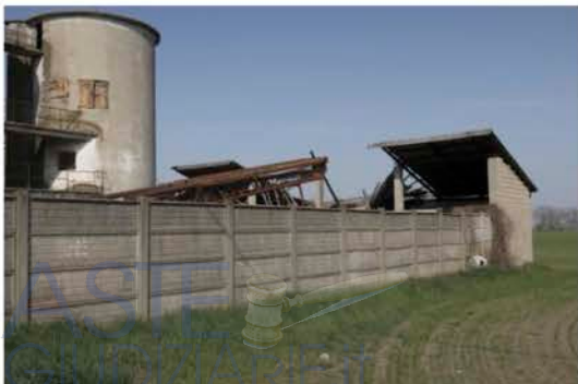
Muro di recinzione sui campi
