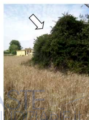
Cabina del gas metano
