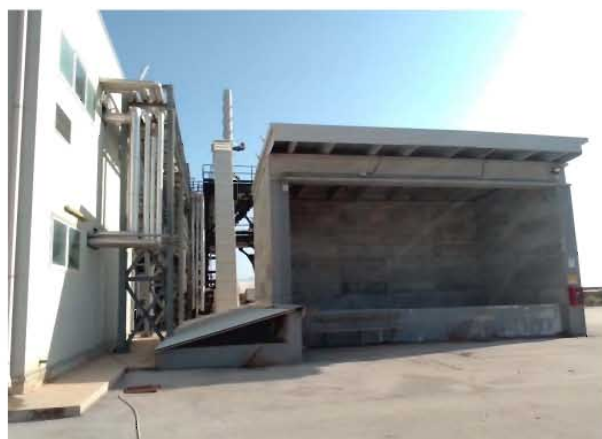
comparto della Centrale Biomassa - binario
