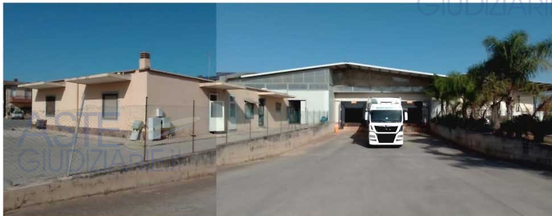
Vista edificio civile e accesso automezzi a reparto
