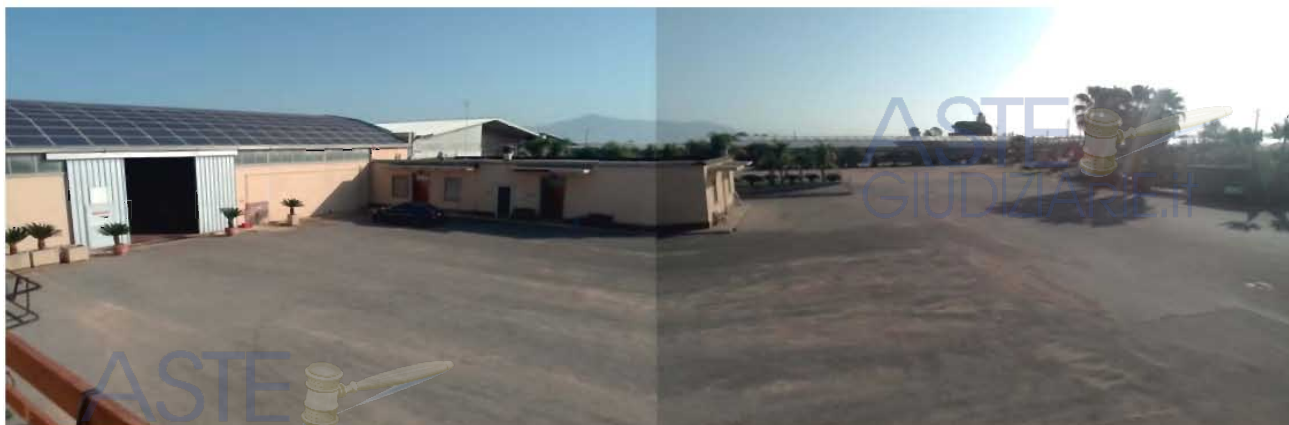
Vista panoramica piazzale interno lato Sud-Est
