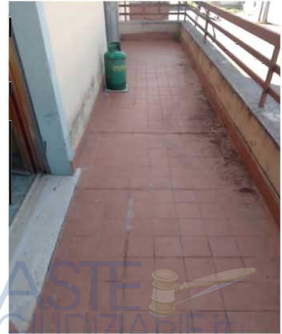
balcone lato Ovest
