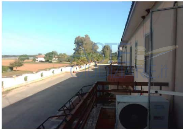
Vista laterale Nord-Ovest
