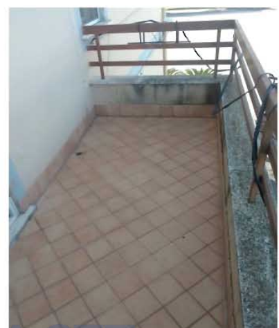
balcone lato Ovest
