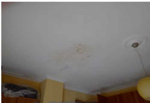
particolare del soffitto - infiltrazioni provenienti dal piano copertura
