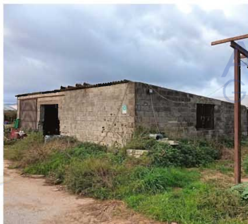
comparto della Centrale Biomassa - deposito
