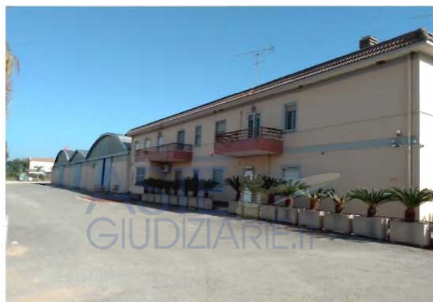
Vista retrofrontale edificio civile e reparto lavorazione
