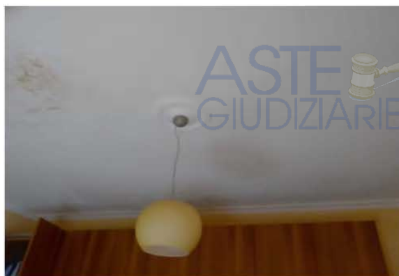
particolare del soffitto - infiltrazioni provenienti dal piano copertura
