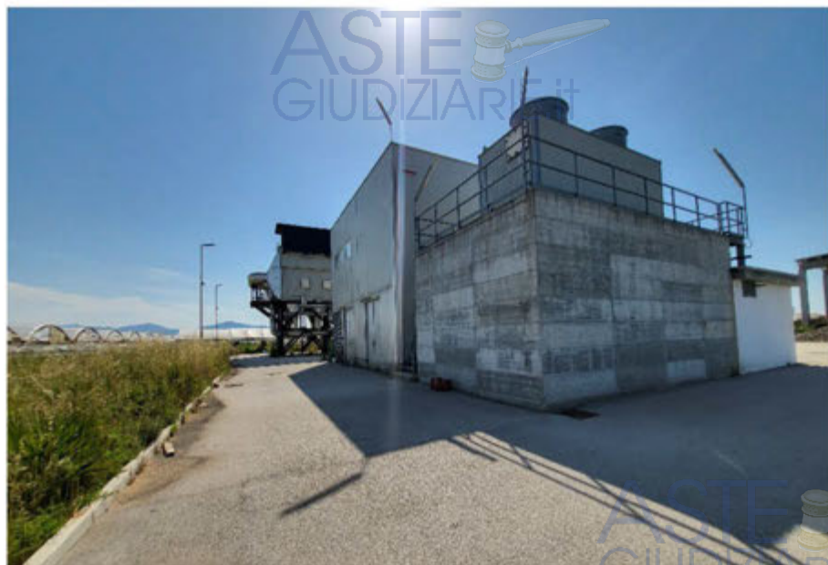
Foto 11: torri evaporative e locale pompe acqua torre
