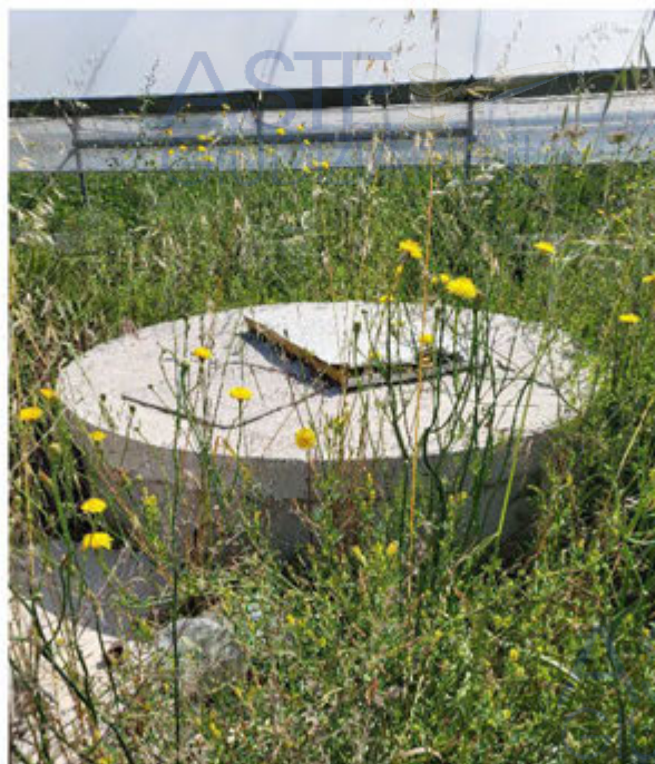
Foto 19: pozzo approvvigionamento idrico centrale
