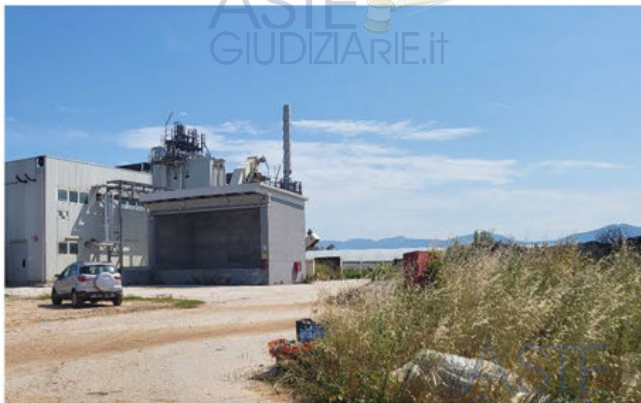
Foto 5: sistema carico e scarico automatizzato
