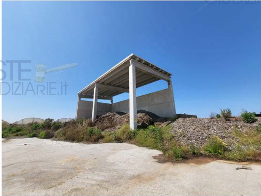
Foto 12: edificio stoccaggio cippato
