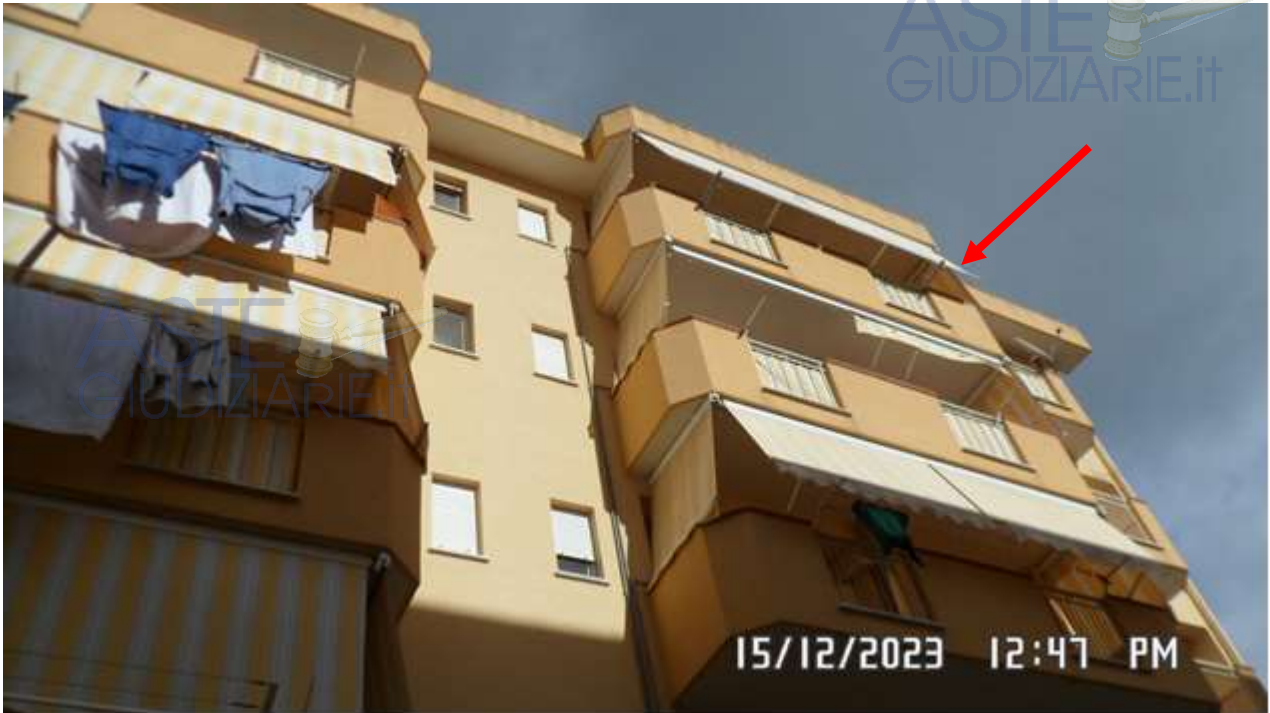
Foto 1 – Veduta dell'appartamento da viale Leonardo Sciascia
