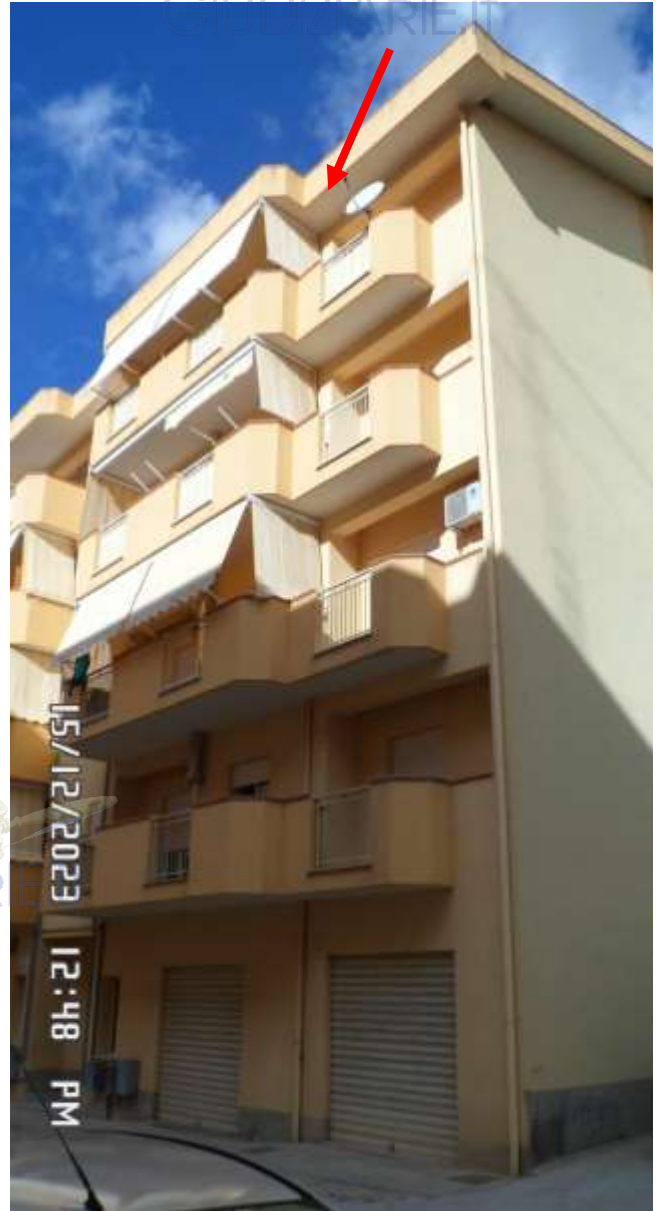
Foto 4 - Veduta dell'appartamento dal Viale Leonardo Sciascia
