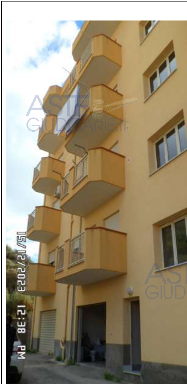
Foto 5 – Veduta dell'ingresso dell'autorimessa
