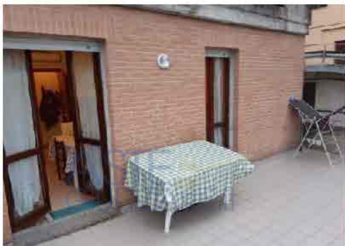
Lotto 9 sub 30 lastrico solare
