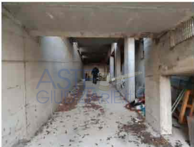
Lotto 16 sub 59 rampa di accesso carrabile
