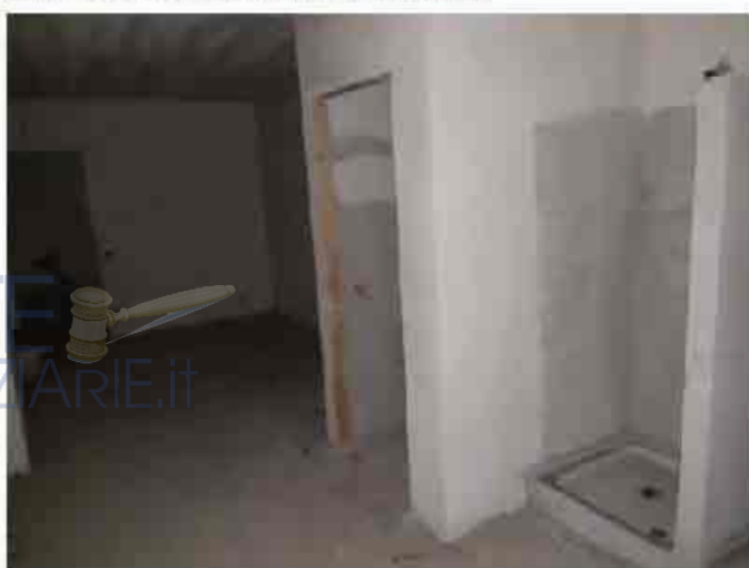
Lotto 16 sub 59 lavatoio
