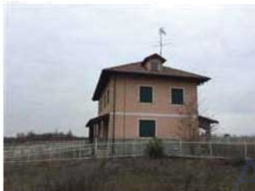
Vista fronte Sud/Ovest
