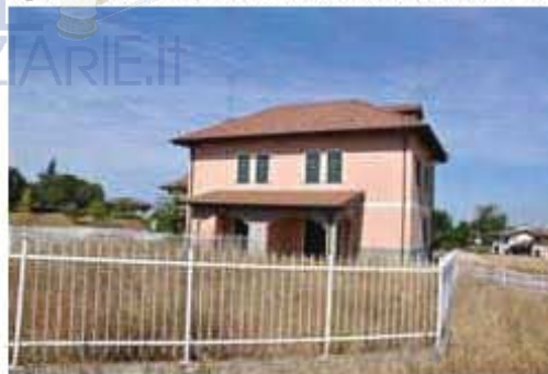
Vista fronte Sud-Est
