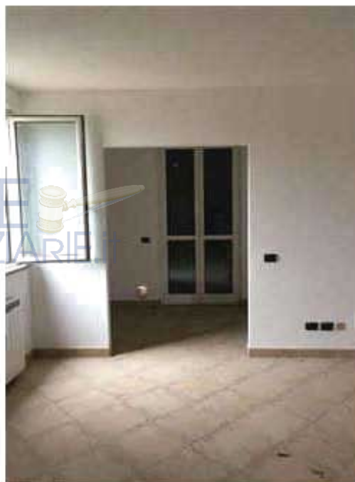
Vista interna Piano Terra
