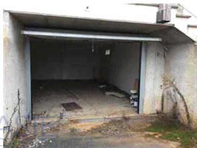
Ingresso BOX cantina
