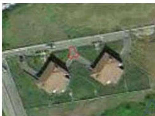
Particolare vista dall'alto del Corpo B
