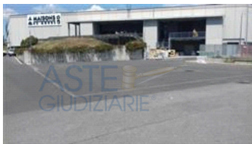
Vista altra corte esterna ad uso parcheggio
