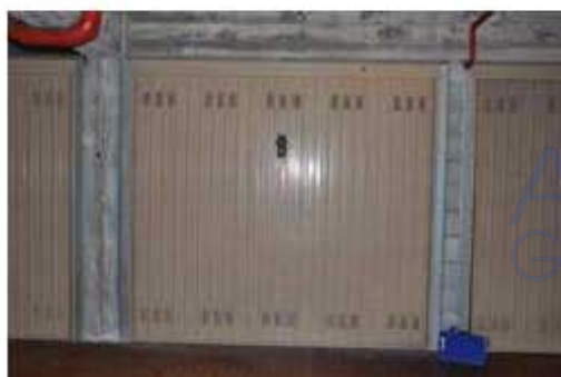
vista esterno box
