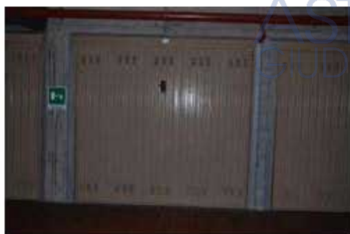
vista box dall'area di manovra
