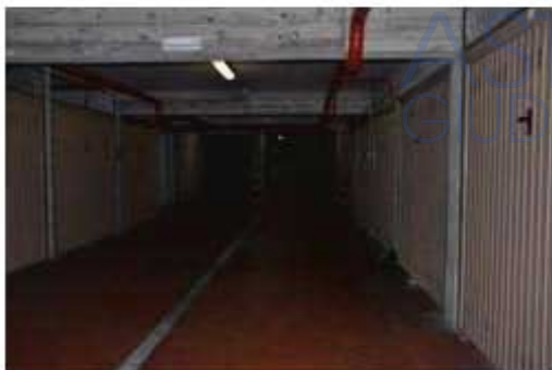
corsia di accesso
