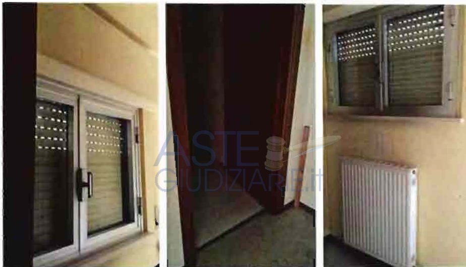
Vista degli infissi
