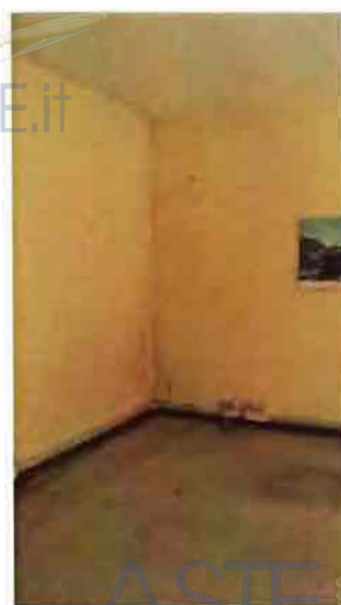
Vista della parete di fondo al civico 75 B
