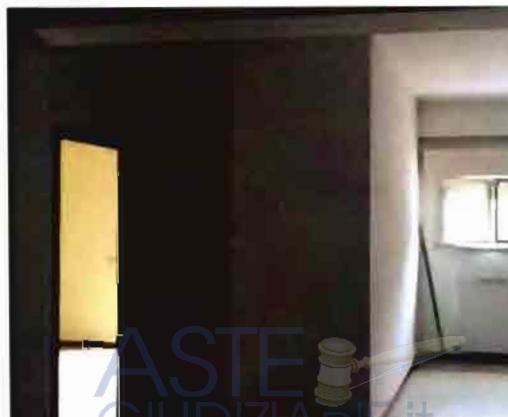
Vista della porta di collegamento e della zona di antibagno
