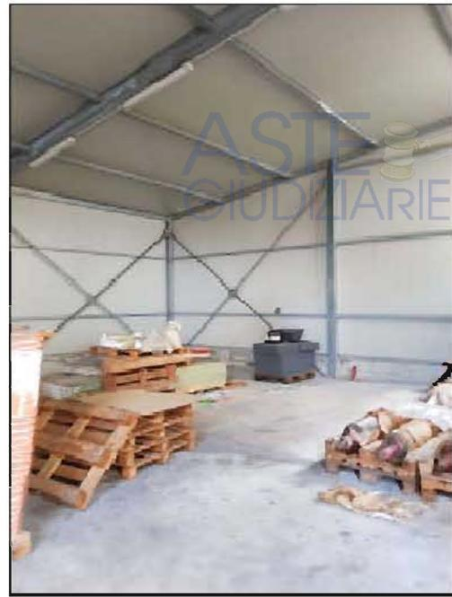
La copertura a falda unica inclinata è composta da pannelli esterni in lamiera grecata e pannelli interni dogati, con interposto isolante costituito da schiuma poliuretana espansa.
