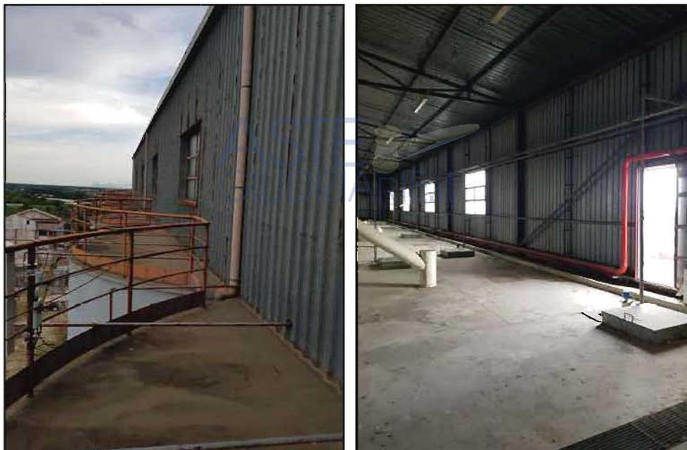
La copertura dei silos è realizzata con un solaio a predalles dello spessore di 20 cm, poggiato su travi in acciaio HEA 340 ancorate con piastre e tirafondi alla sommità delle celle in c.a..
