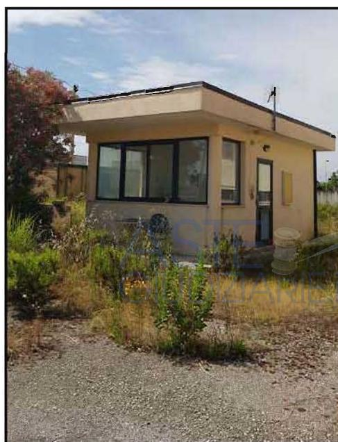
L'edificio è realizzato in cemento armato con strutture di elevazione costituite da pilastri e travi.
