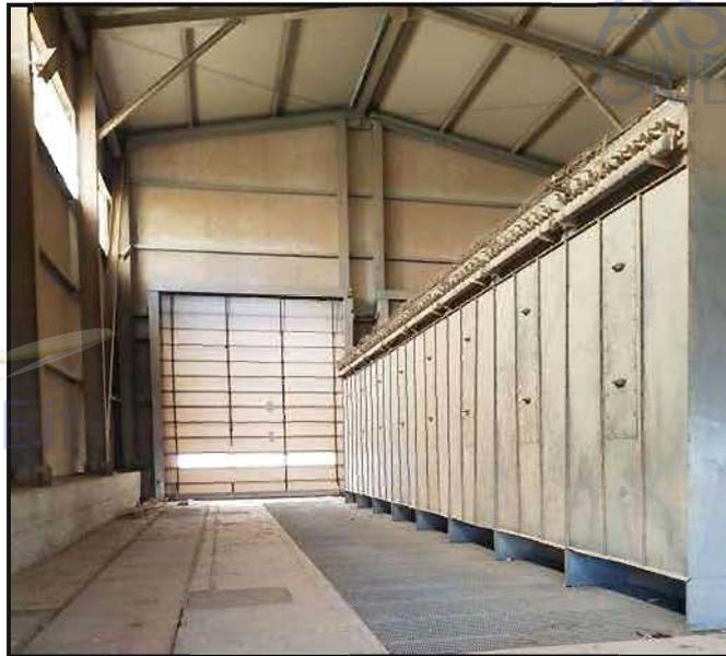
Il capannone è realizzato con struttura portante metallica su fondazione diretta a plinti in c.a., uniti da travi di collegamento. Gli elementi verticali sono collegati ai plinti mediante tirafondi metallici.
