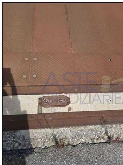
Nella zona ingresso allo stabilimento, in corrispondenza della *Palazzina Uffici*, è ubicata una pesa a ponte, delle dimensioni, in pianta, di 18,00 m x 3,00 m.
