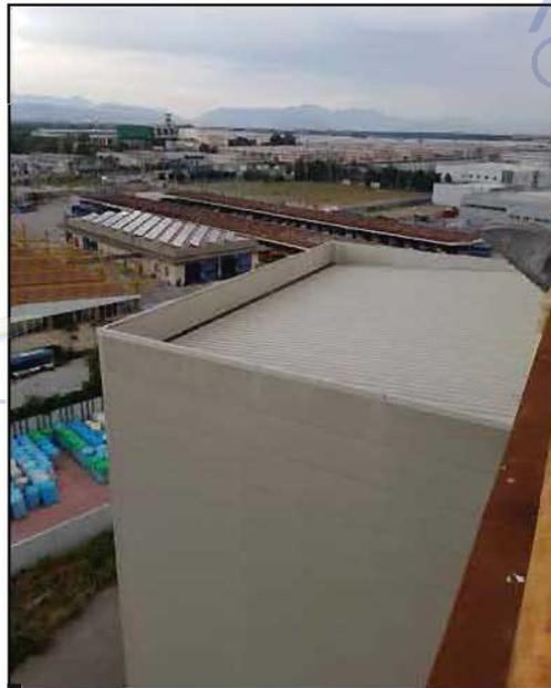
Le scossaline sono in lamiera metallica zincata e le pluviali in lamiera preverniciata di diametro 100 mm, con pozzetto di ispezione in conglomerato cementizio, posizionato al piede.
